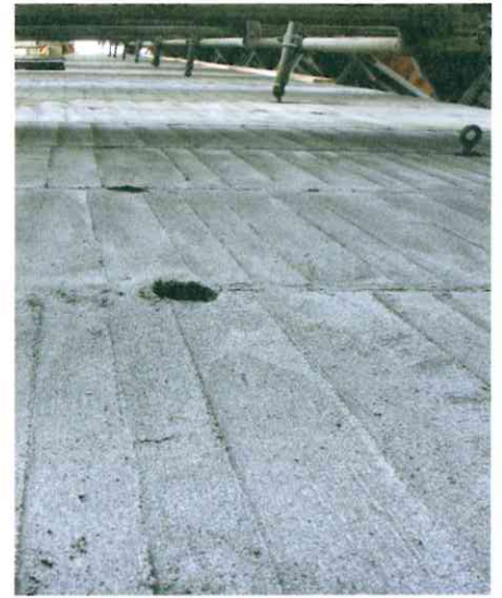
Abb. 6: Die fertige Oberfläche vom Gerüst aus gesehen (Foto: Klaus Zolondowski)
