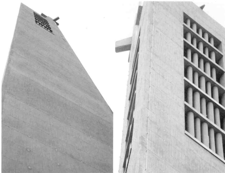
Abb. 3a und b: Bei der Instandsetzung des unter Denkmalschutz stehenden Kirchturms der Berliner Kirche St. Judas Thaddäus gingen alle Beteiligten neue Wege (Fotos: Rita Jacobs)
