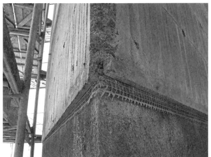
Abb. 4: Eine zusätzliche Bewehrung aus Carbongewebe sorgt für Nachhaltigkeit (Foto: Klaus Zolondowski)
