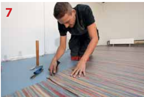
7 Entlang der Anrisslinie wird mit leichtem Unterschnitt die Naht gefertigt, spannungsfrei eingepasst und zuletzt angerieben.
