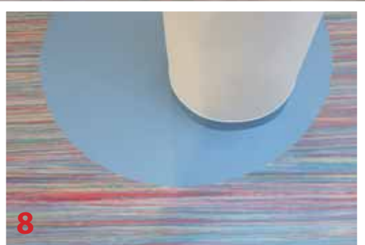
Das Ergebnis kann sich sehen lassen: Was andere nur mit Wasserstrahltechnik können, setzt das Team von Mike Zimmermann in perfekter Handarbeit um.
