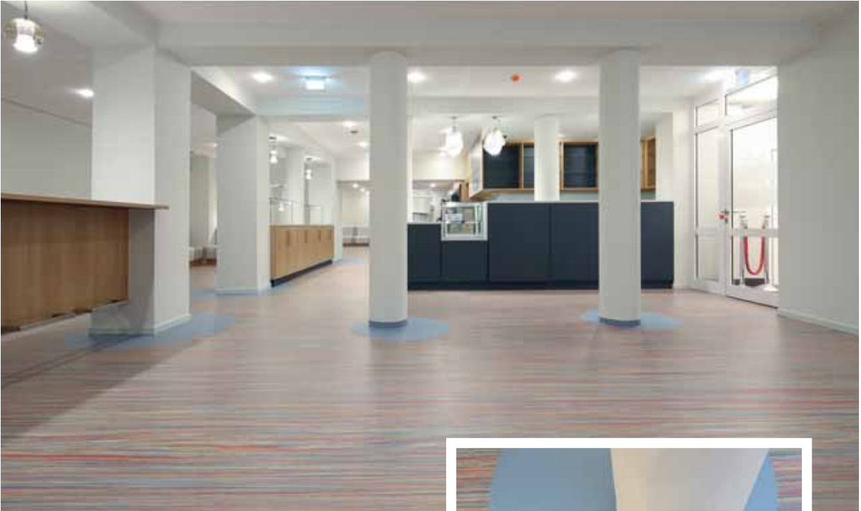
Das längs gerichtete Striato-Muster mit den eingearbeiteten Kreissegmenten und den unverfugten Nähten hat eine harmonische Flächenwirkung.
